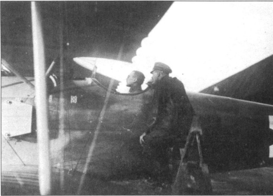
В кабине «Альбатроса» D II D.1717/16 летчик 14-го штаффеля Пауль Бертольд, аэродром Бюль. Фюзеляж вероятно красно-коричневый. Обратите внимание на радиатор на фюзеляже. Радиатор увеличивал лобовое сопротивление аэроплана, на поздних моделях «Альбатроса» радиатор перенесли в крыло.
